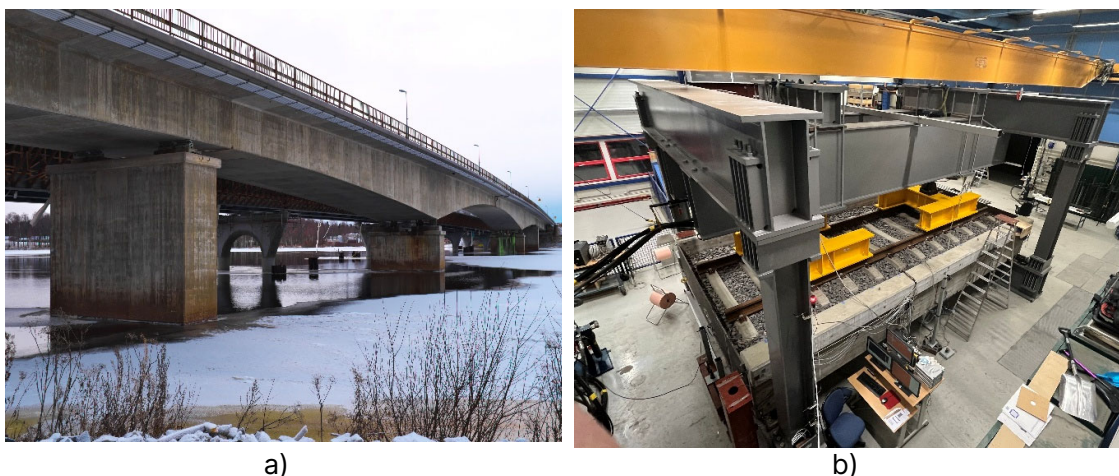
Figur 1. a) Den gamla E4-bron över Kalixälven, en förspänd betonglångbro byggd med balanserad konsolutkrågning. Den undersöktes inom projektet före rivning; b) Trågbro i full skala gjuten och testad vid LTU
